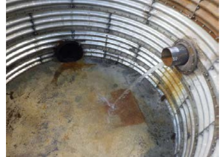
排水管布設完了
